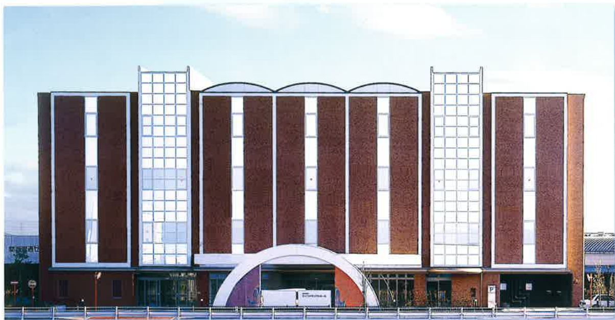
※写真は、摂津市立葬儀会館「せつつメモリアルホール」
